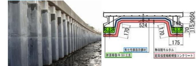
脱塩処理 + 超高強度繊維補強コンクリートパネル取付工法で、氷塊の衝撃に対応
