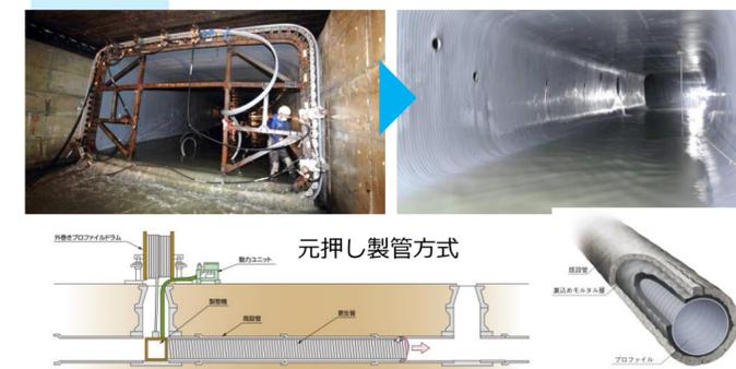
既設管の内側に塩化ビニル製プロファイルを螺旋状に製管し、裏込め材を注入。既設管と一体化した複合管を築造
