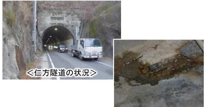
覆工コンクリートの剥落・貫通ひびわれ
