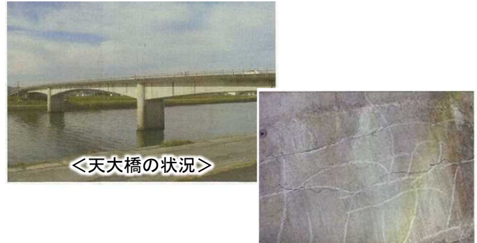
下部工のひび割れ
