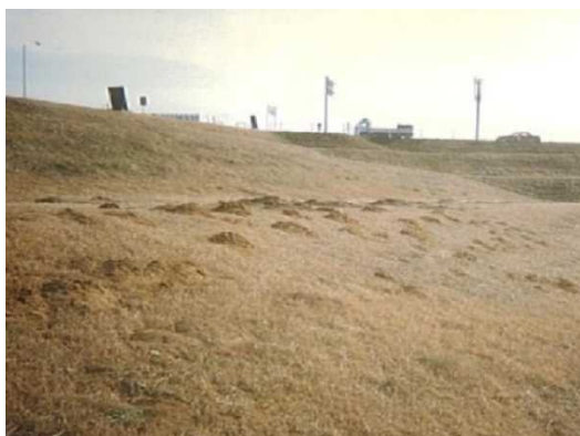
写真 2-10 堤防法面のモグラ塚と、地中のモグラの巣の状況
