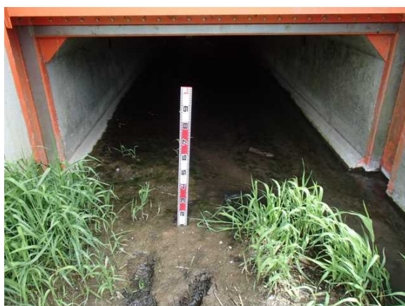
写真 2-43 樋門吐口の土砂堆積
