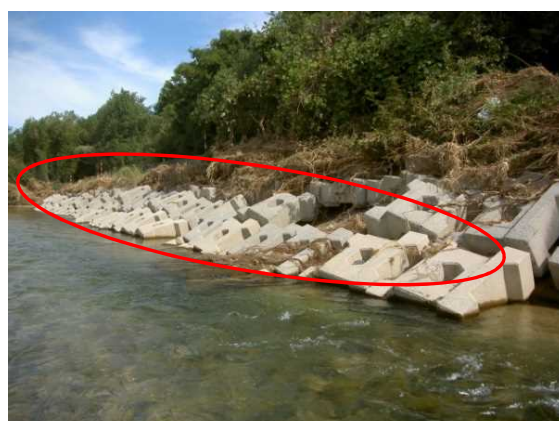
写真 2-30 根固工の変状
