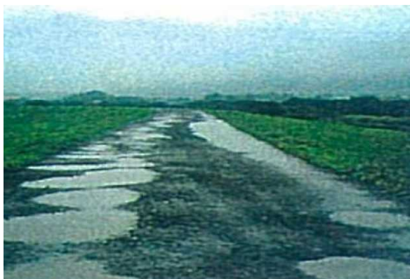
写真 2-13 堤防天端の陥没(水たまり)
