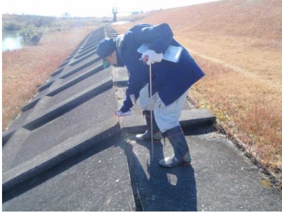
写真 2-21 変状箇所のマーキング状況
