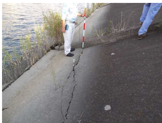
写真 2-28 護岸の亀裂
