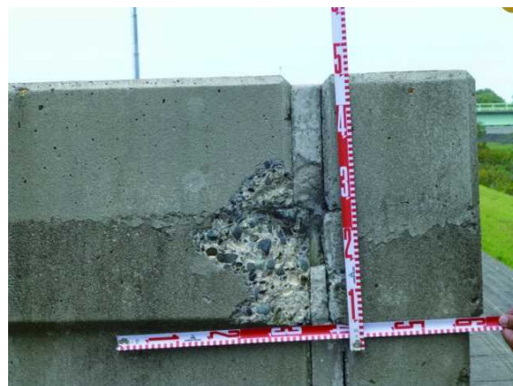
写真 2-41 特殊堤: 胸壁コンクリート剥離
