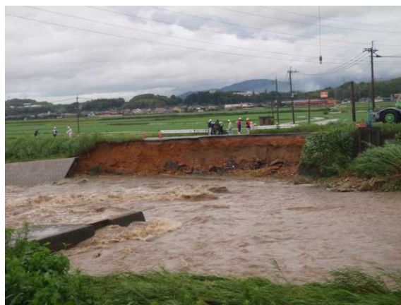
写真 2-45 固定堰:取り付け護岸の被災
