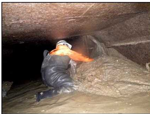
写真 2-51 構造物接合部からの吸い出し
