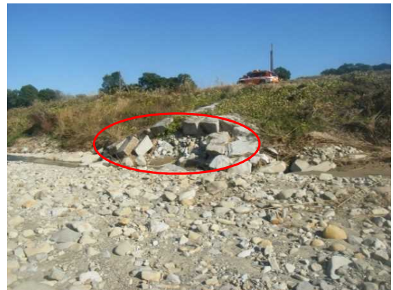
写真 2-32 水制の破損
