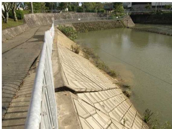
写真 2-47 積み構造のはらみだし
