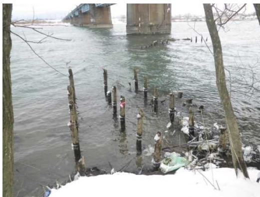
写真 2-48 木杭水制の損傷状況
