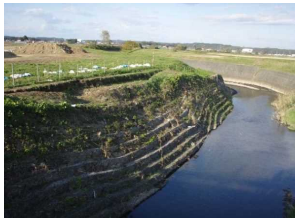
写真 2-47 積み構造のはらみだし
