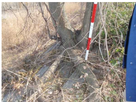
写真 2-11 堤防、護岸部の樹木進入状況
