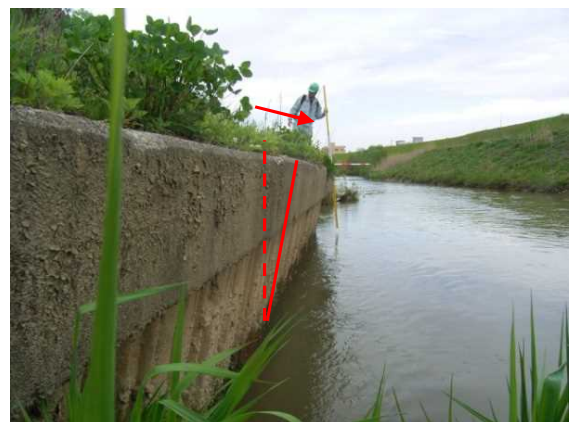
写真 2-34 低水護岸(矢板)の傾倒状況
