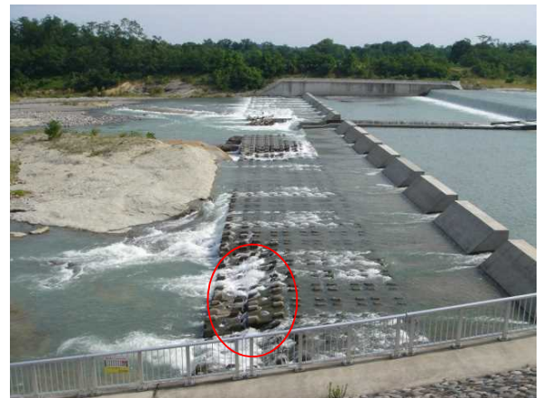
写真 2-39 床止めの不同沈下
