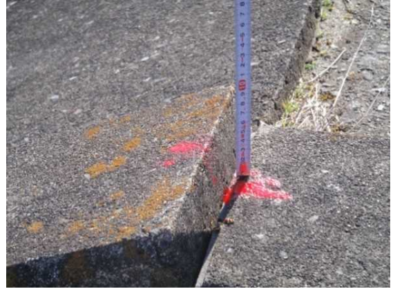
写真 2-21 変状箇所のマーキング状況
