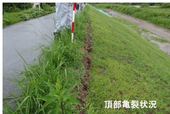
写真 2-14 堤防天端の亀裂
