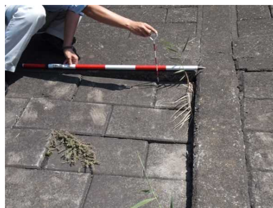
写真 2-24 護岸の沈下陥没状況
