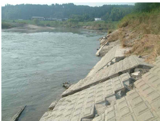
写真 2-57 局所洗掘による護岸の変状
