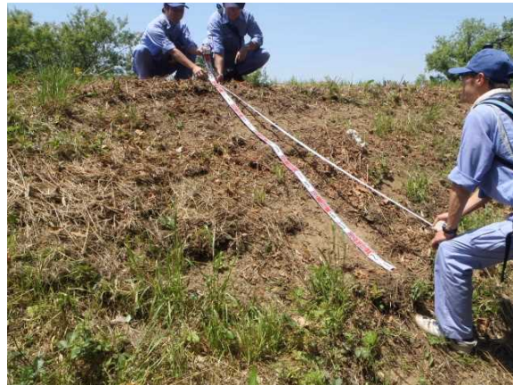
提供:下館河川事務所(小貝川)
