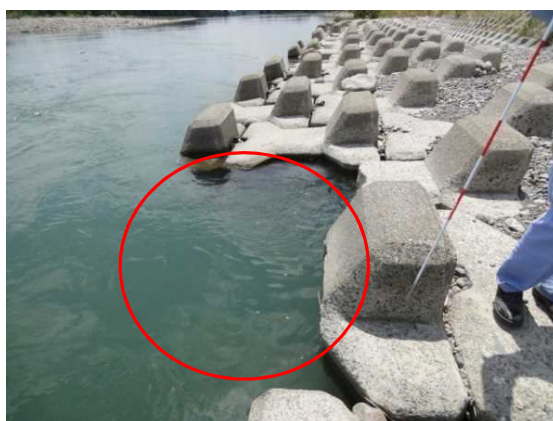
写真 2-29 根固工の欠損
