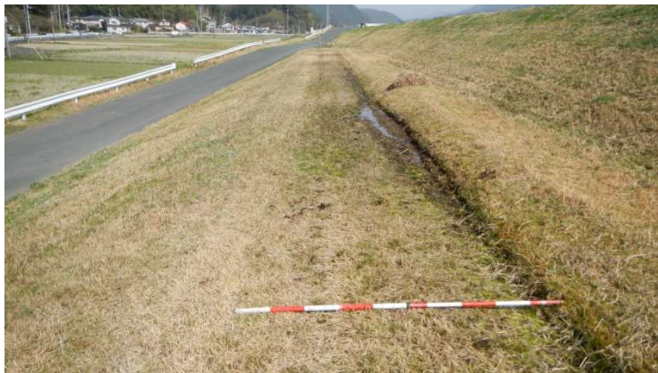
写真 2-8 小段逆勾配による雨水排水不良
