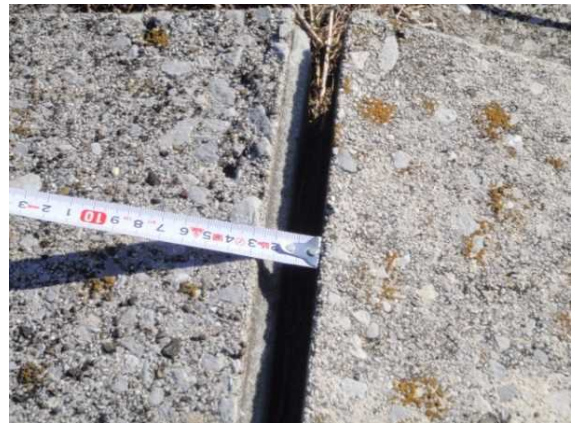
写真 2-20 亀裂幅、目地開き幅の確認状況
