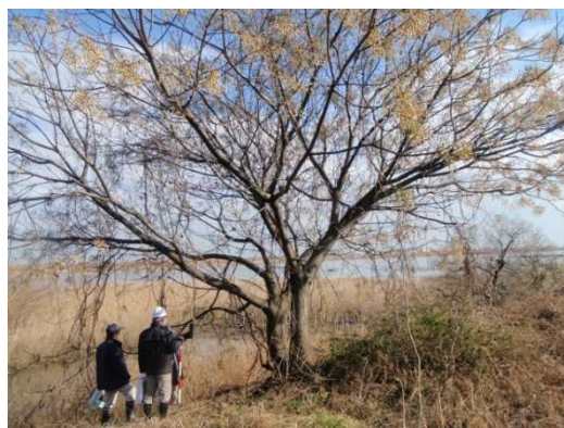
写真 2-11 堤防、護岸部の樹木進入状況
