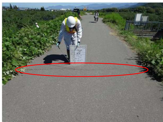
写真 2-18 構造物上部に発生したクラック
