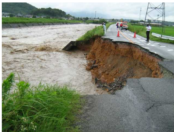
写真 2-45 固定堰:取り付け護岸の被災
