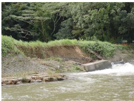
写真 2-46 積み構造の崩れ
