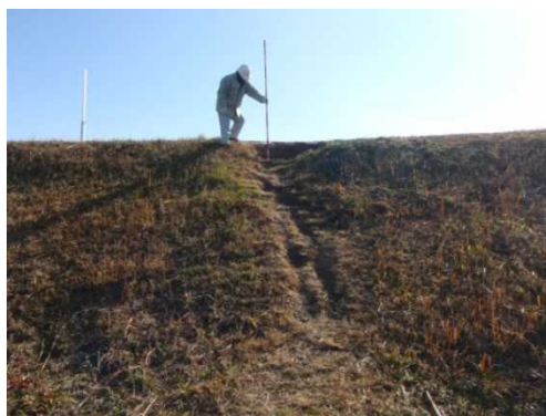
写真 2-12 堤防天端道路からの路面排水による法面侵食
