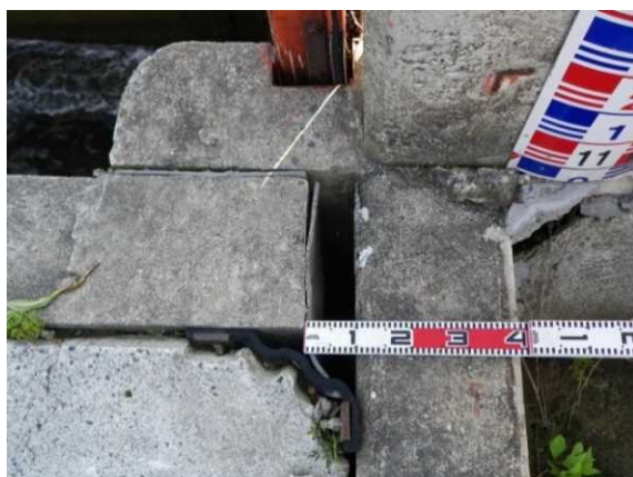
写真 2-49 樋門:胸壁と翼壁の継手の目開き
