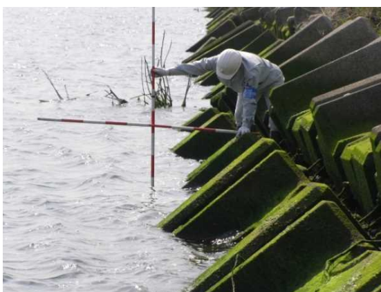
写真 2-33 根固工前面の河床低下状況確認
