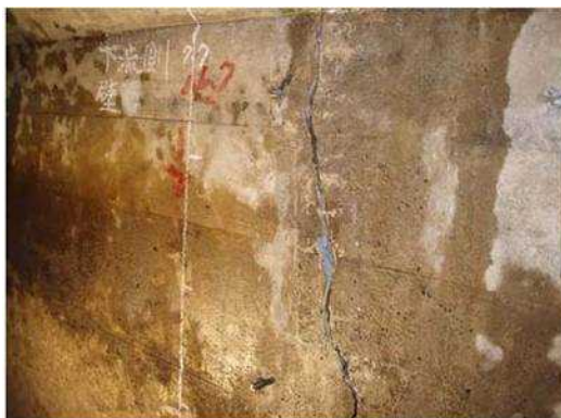
写真 2-52 樋門函体のクラック
