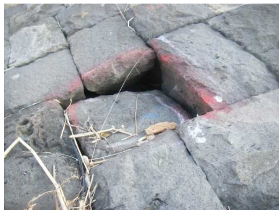
写真 2-27 護岸の破損
