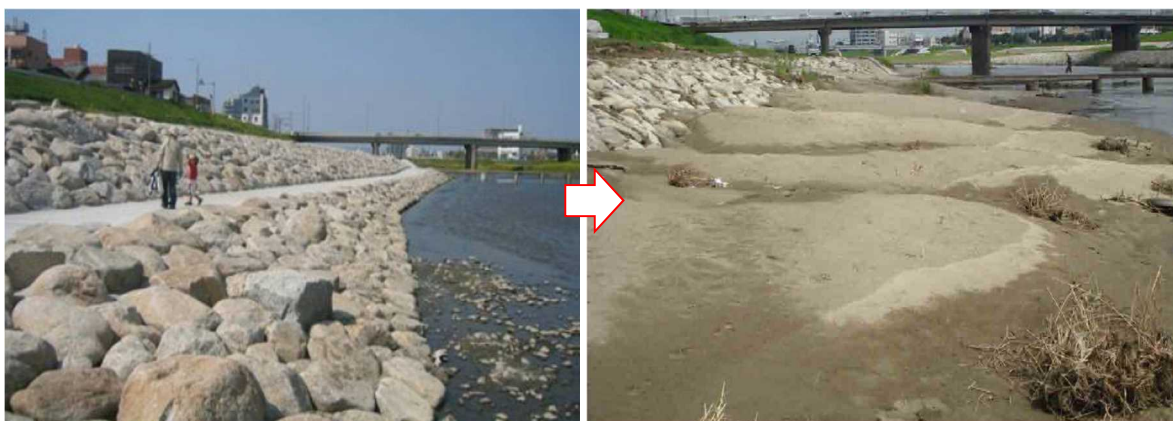
写真 2-53 洪水による土砂堆積
