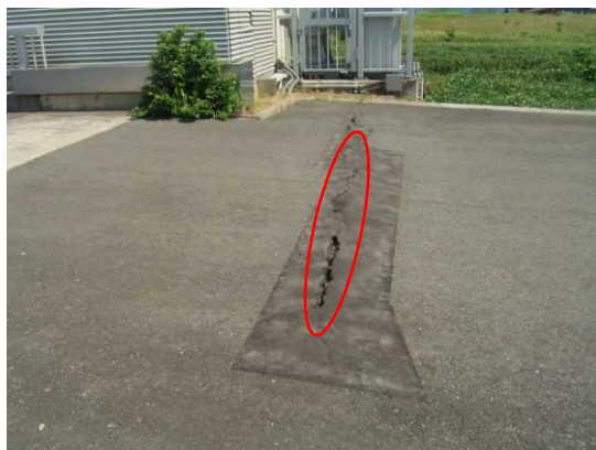
写真 2-18 構造物上部に発生したクラック
