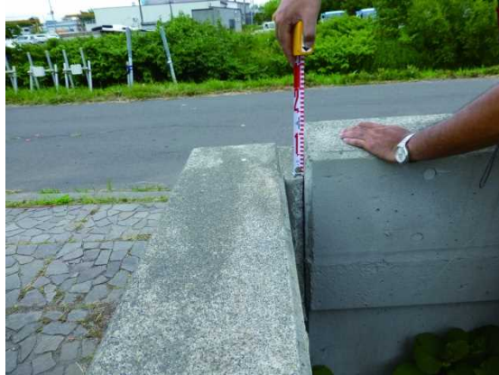
写真 2-37 特殊堤:本体の不同沈下
