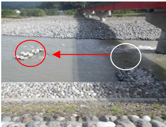
写真 2-31 水制工の流出
