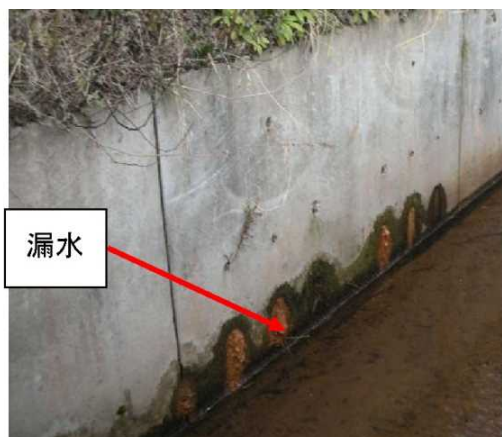
写真 2-17 堤脚水路からの漏水
