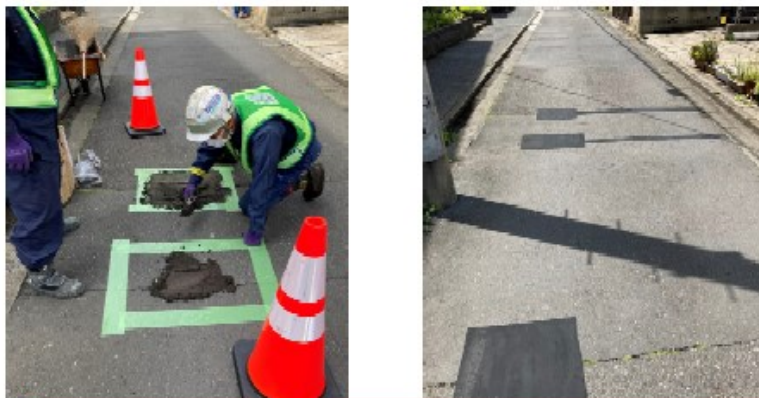
高耐久段差修正材（自社製）等の活用
