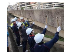
学生による橋梁点検体験
