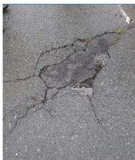
アドバイザーによる、現地踏査での課題の特定(舗装異常)
