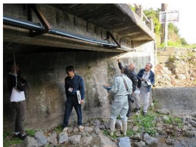
アドバイザーが日常管理方法や、導入技術の要件を確認するための現地踏査の様子
