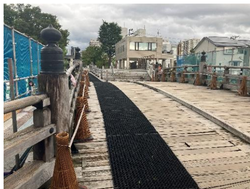
アドバイザーによる 木橋詳細調査の様子
