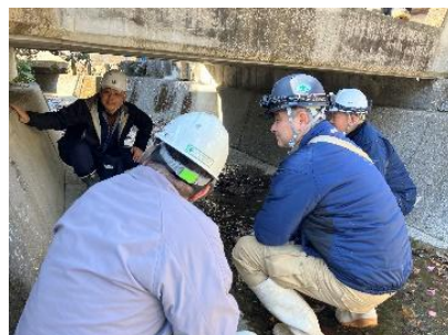
直営点検や簡易補修方法の勉強会の様子
