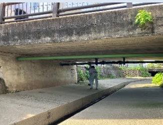
点検試行の様子
