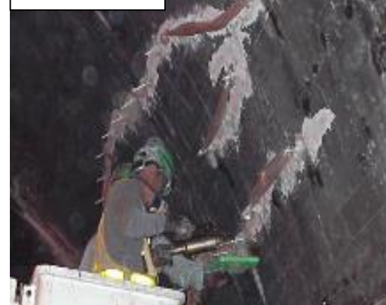
ひび割れ注入による補修
