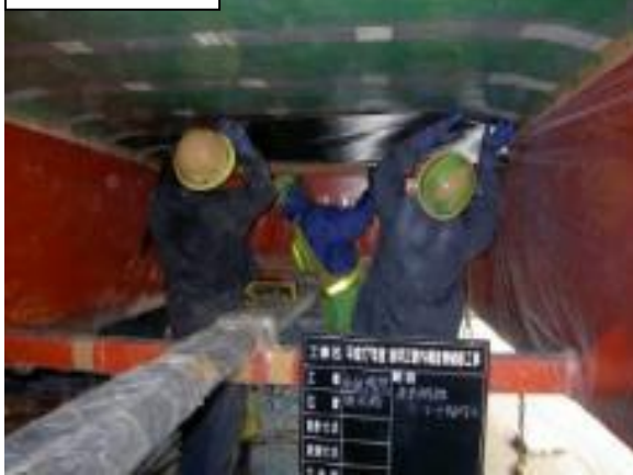
炭素繊維シートによる補修
