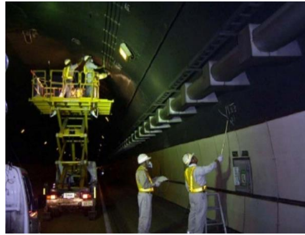
トンネル定期点検
