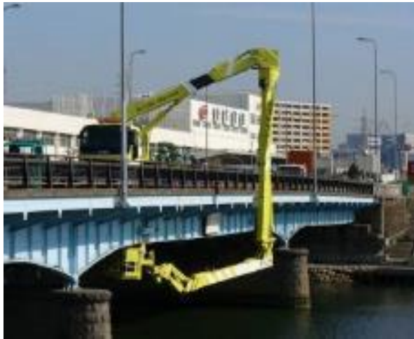
橋梁定期点検
