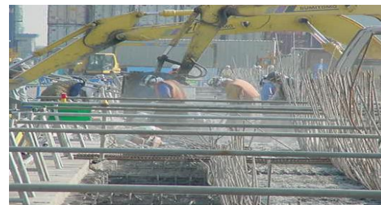
▲ 床版の打ち替え
