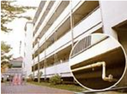
<配管のメンテナンス>
