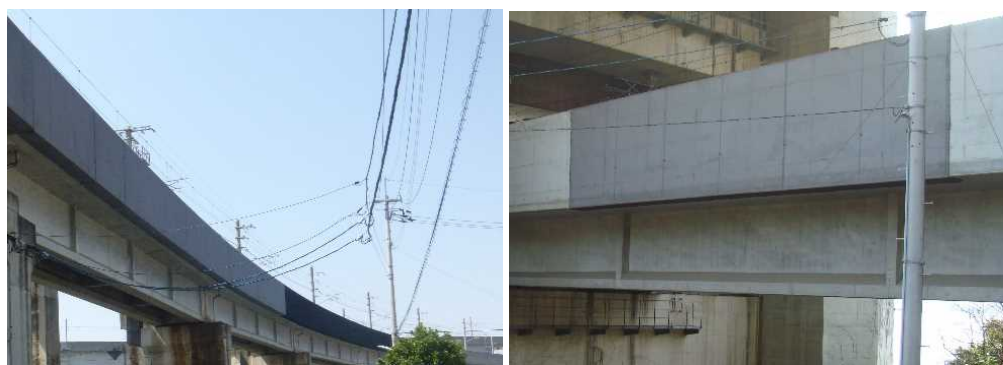
樹脂系ネットによる剥落防止工の施工事例
