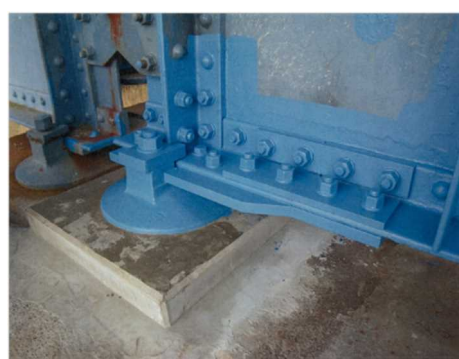
部材の取替えを行った例
