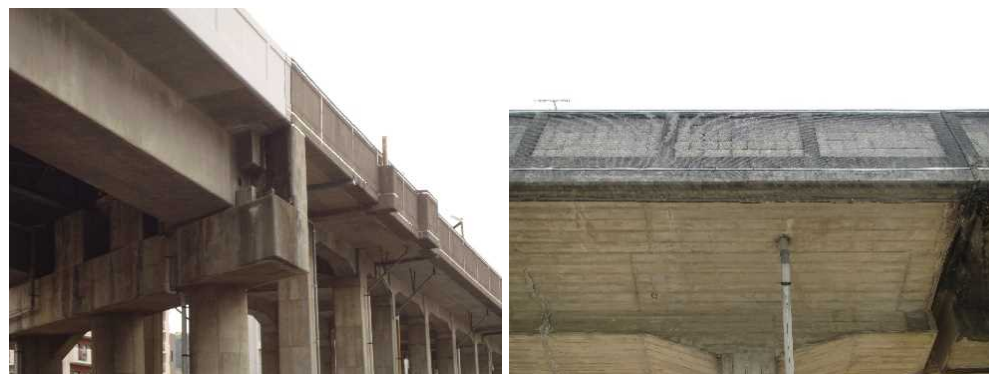
金網による剥落防止工の施工事例
