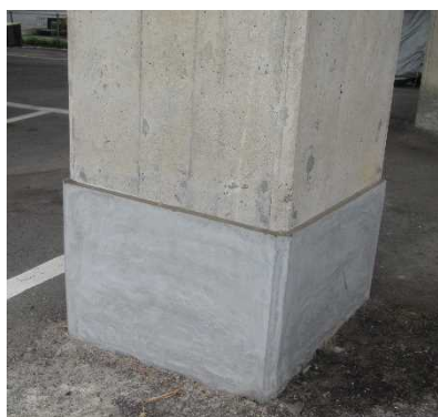
断面修復の実施工例（部分断面修復）
