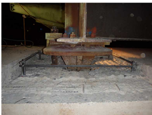
沓座はつり状況
