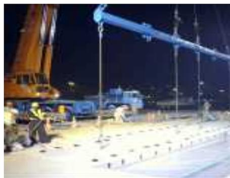
写真 5.2.32 PRC 版の設置状況
