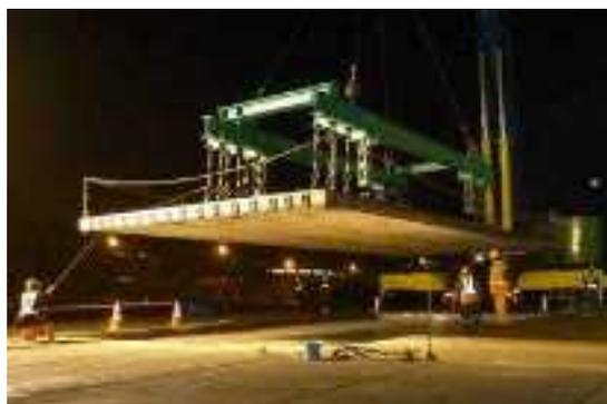
写真 5.2.30 PPC 版仮据付け状況
