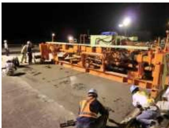
写真 5. 2. 24 フィニッシャによる締め固め状況
