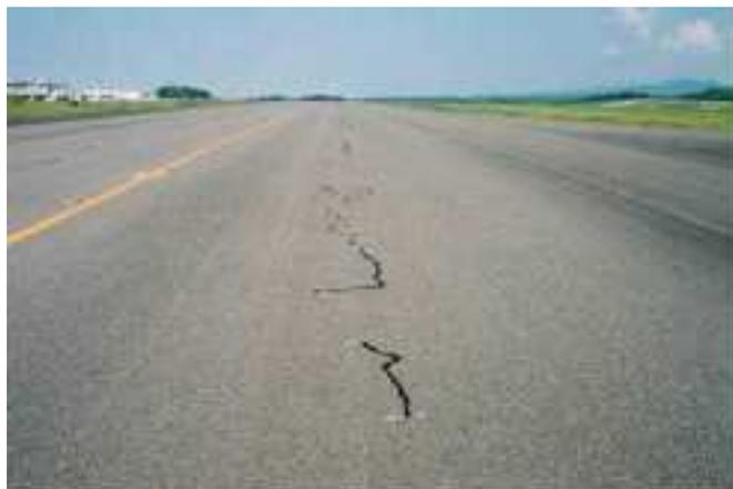
写真 5.1.1 ひび割れ注入後の状況
