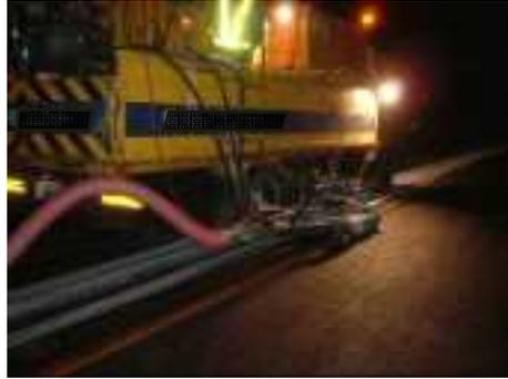
写真 5.1.8 ゴム除去施工状況
