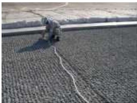
写真 5.2.12 目地部バックアップ材設置
