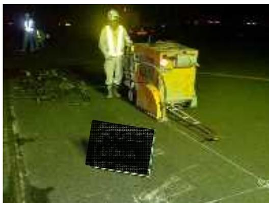
写真 5.1.4 舗装版切断状況
