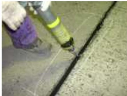
写真 5.2.3 目地材の注入状況
