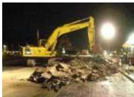
写真 5.2.17 既設コンクリート版撤去状況
