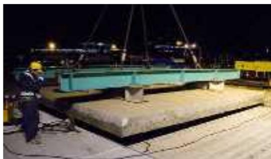
写真 5.2.29 既設コンクリート版吊上げ状況
