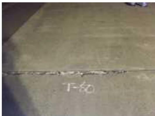
写真 3.1.23 目地部の破損
