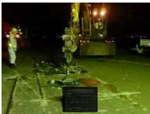
写真 5.1.5 舗装版撤去状況
