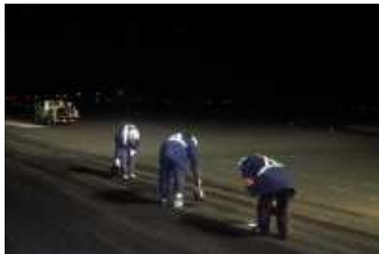
写真 5.1.2 ひび割れ充填材の注入状況
