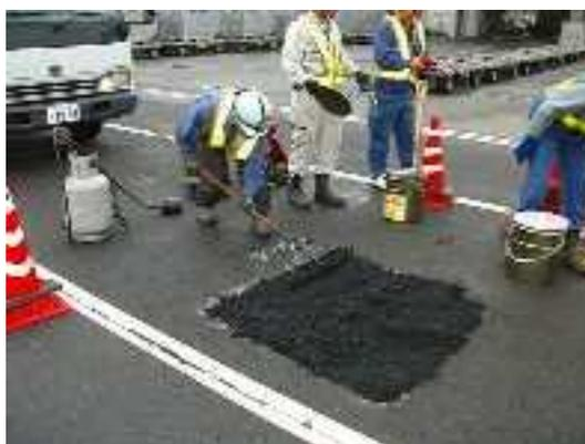
写真 5. 1. 3 常温混合物によるパッチング工の施工状況
