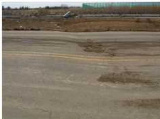
写真 4.3.3 大規模地震に伴う誘導路の沈下状況（例）
