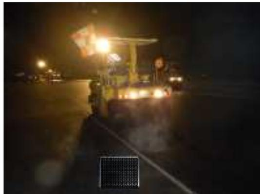
写真 5.1.13 舗装転圧施工状況
