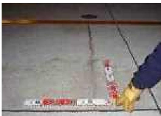
写真 3.1.17 ひび割れ（横断方向）
