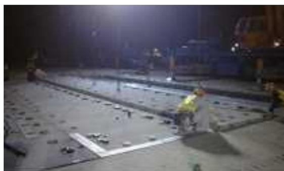
写真 5.2.33 PRC版仮据付け状況
