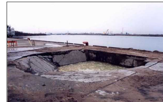
陥没した港湾施設のエプロン
