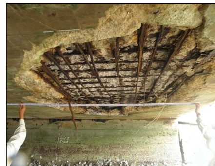
内部の鉄筋が露出した橋梁
