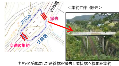
老朽化が進んだ跨線橋を撤去し隣接橋へ機能を集約
