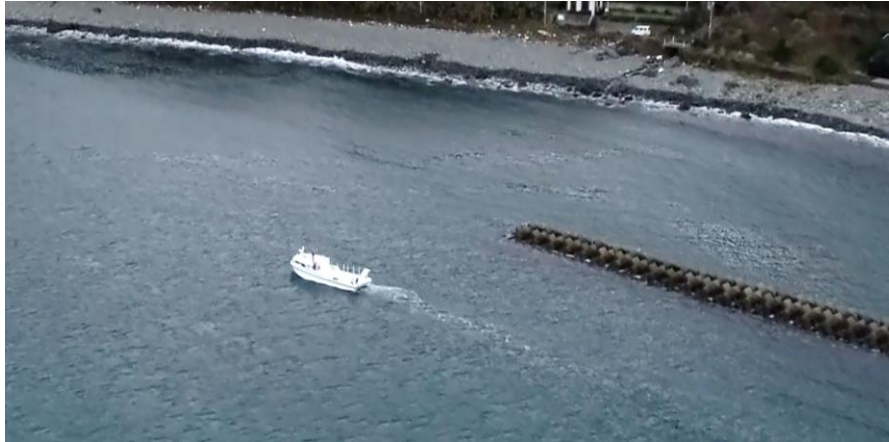
離岸堤の点検状況 (瀬崎)
