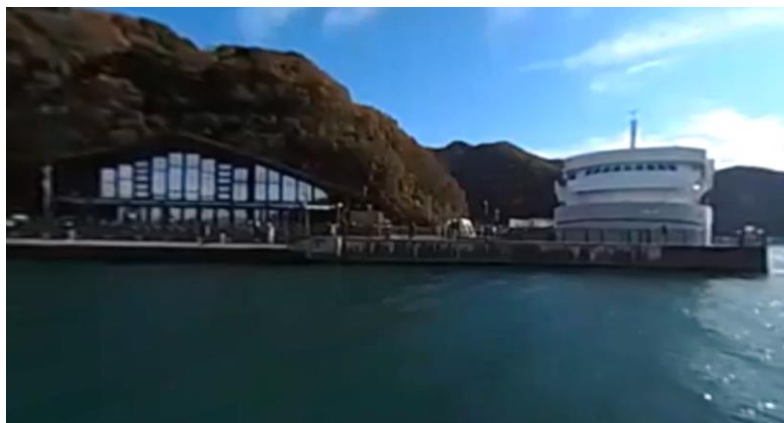
光学カメラ リアルタイム点検状況（360°カメラ）
