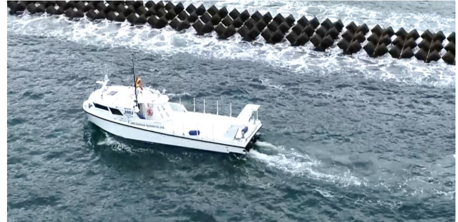
離岸堤の点検状況 (瀬崎)
