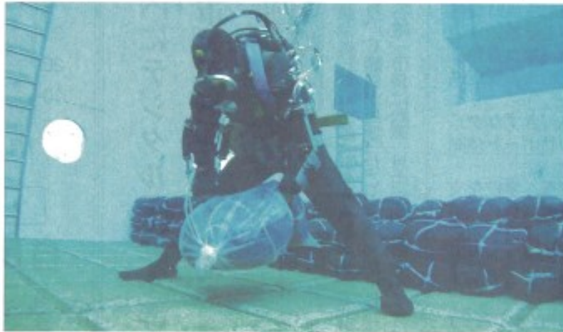
海中作業用パワーアシストスーツを装着し、土のうを運ぶ潜水士。負担軽減の効果を実感したという
