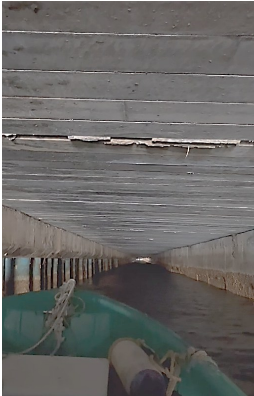
海上の狭い空間で目視点検を実施
