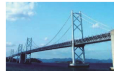
本四連絡橋（瀬戸大橋）
