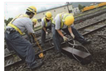
鉄道施設の修繕
