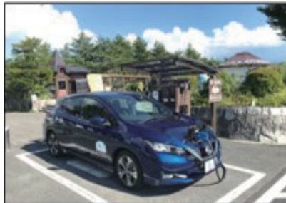
道の駅でのEV充電器の設置
