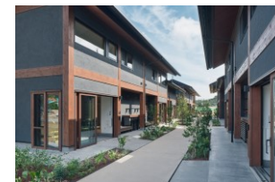
帰還者向け災害公営住宅等建設地 (双葉町 双葉駅西側地区)
