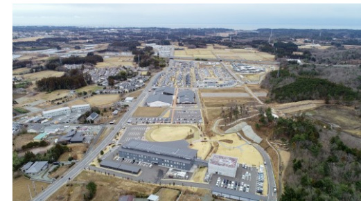
福島復興再生拠点整備事業 (大熊町 大川原地区 R3.3完了 R5.1撮影)
