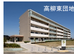
災害公営住宅整備 (宮城県名取市)
