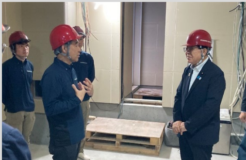
住宅建築の現場
