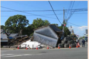
建造物の倒壊等（八代市松浜軒）
