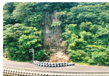
山腹崩壊による土砂流出
