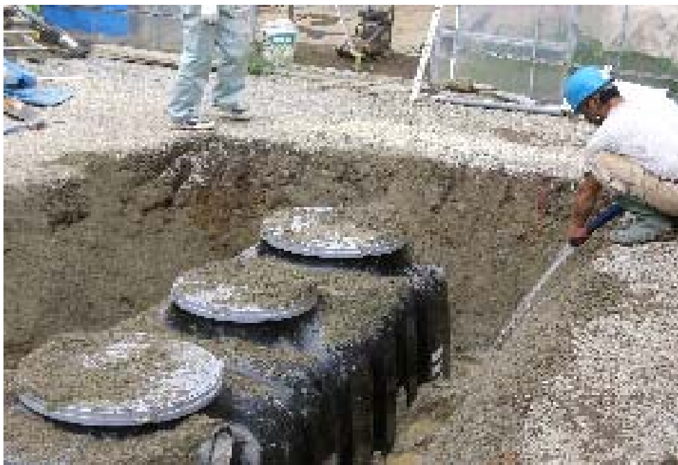
浄化槽本体埋め戻し作業
