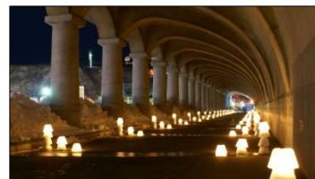
北防波堤ドーム: (昭和11年完成)ギリシア建築様の円柱とアーチ屋根を持つ防波堤(北海道土木遺産)
