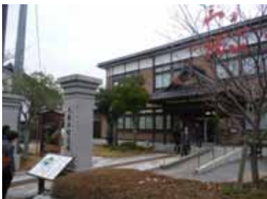
旧久美浜町庁舎(協議会事務所)
