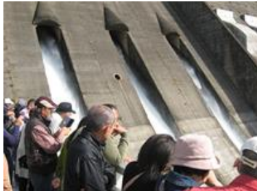
鶴田ダム(点検放流)見学の様子
