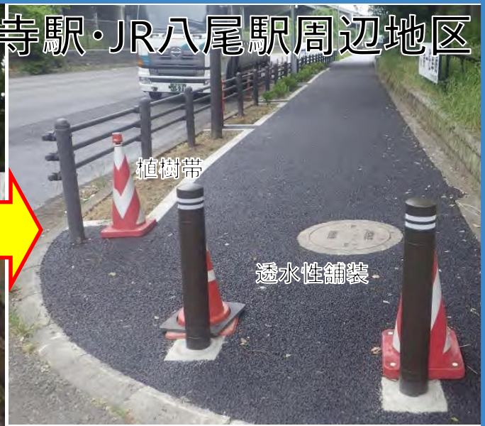
【対策後】 雨水貯留浸透機能の確保
