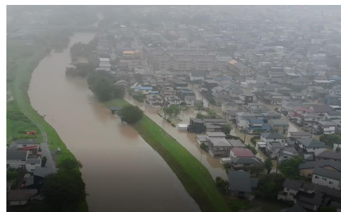
令和5年7月 秋田県秋田市内の浸水状況
