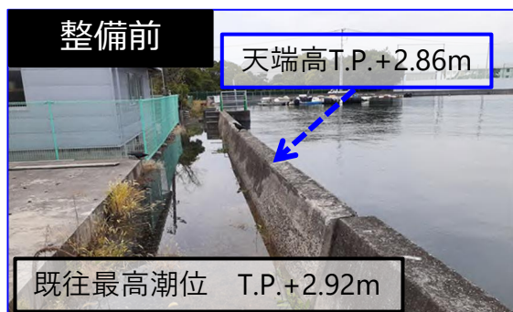
整備前の護岸の状況（江波）
