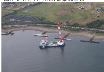
離岸堤の修繕 (積み増し)
