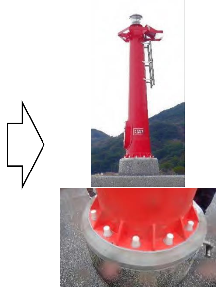
遮断措置を実施したアンカーボルト
