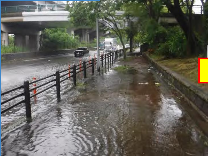
【対策前】 令和3年5月冠水
