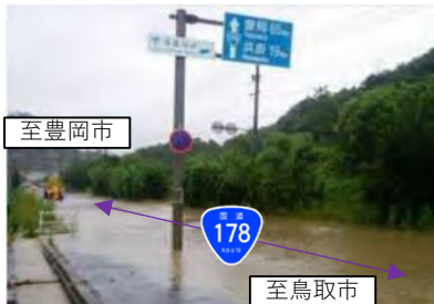
※ 国道178号 現道冠水状況（平成25年9月4日撮影）
