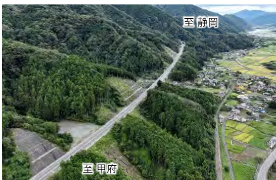
▲写真② 中部横断自動車道（令和5年9月）
