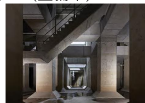
黒目川・黒目橋調節池
