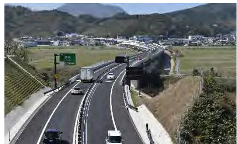
※ 岩美道路 浦富高架橋
