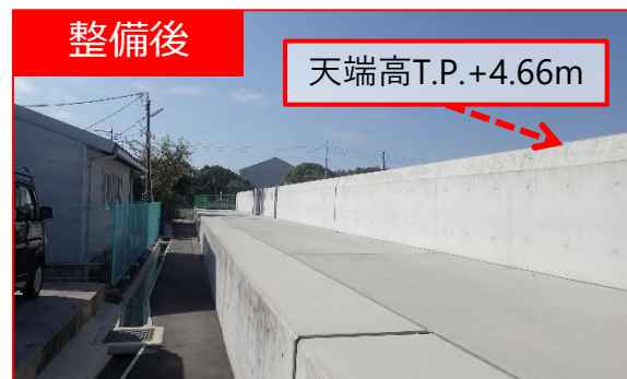
整備後の護岸の状況（江波）
