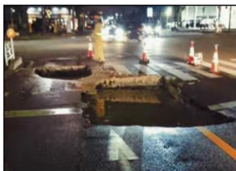
下水道に起因した道路陥没
