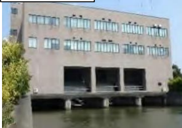
前川排水機場
