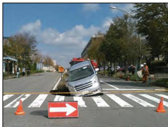
下水道に起因した道路陥没
