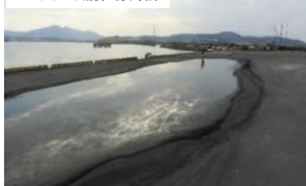
コンクリート舗装の沈下状況
