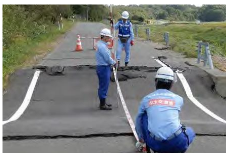
検尺テープ等による被災箇所の測定
