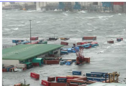
浸水による蔵置コンテナの流出
