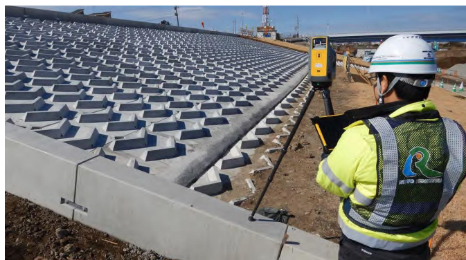
構造物工において3次元計測機器を活用した施工管理を実施
