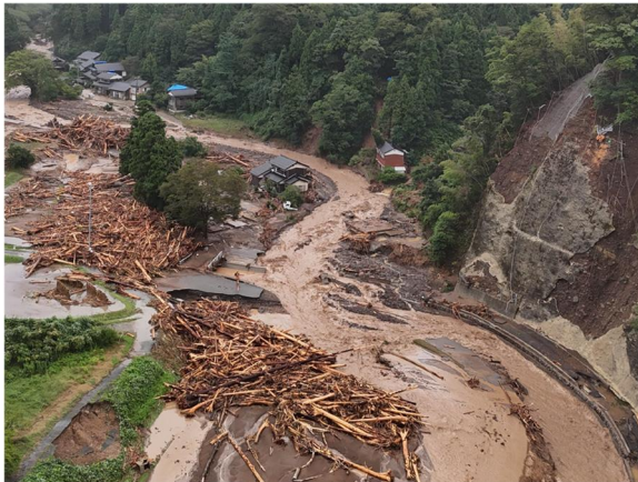
出典：令和6年9月20日からの豪雨による災害発生から1ヶ月の北陸地方整備局の取組（北陸地方整備局）
