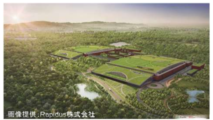
次世代半導体工場周辺のインフラ整備
