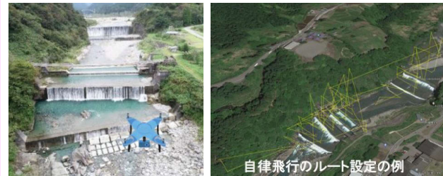
▼ UAVを活用した砂防施設点検の効率化
