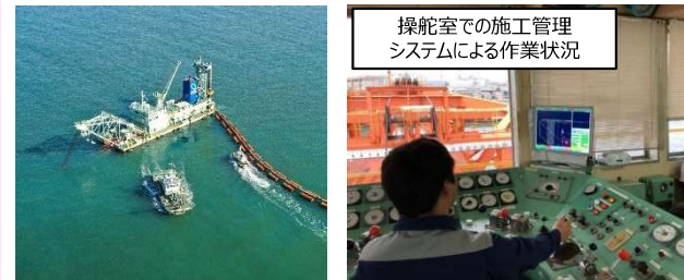
▼金沢港におけるICT浚渫工【石川県】
