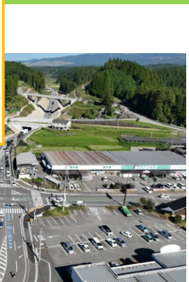
九州横断自動車道 山都通潤橋IC(R6.2.11開通) (熊本県)
