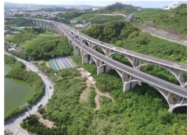
▲国道506号南風原アーチ橋
