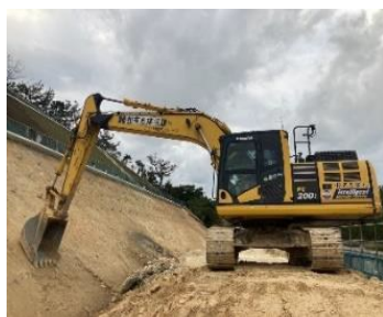
▲ICT 土工施工状況
