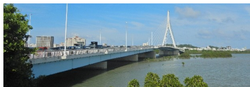
▲国道329号老朽化対策(とよみ大橋)
