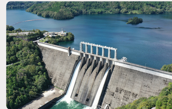
早明浦ダムの役割や仕組みを見学 (高知県 早明浦ダム)
