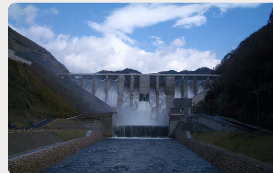
「ラビリンスなダム」 苦田ダム見学 (岡山県 苦田ダム)
