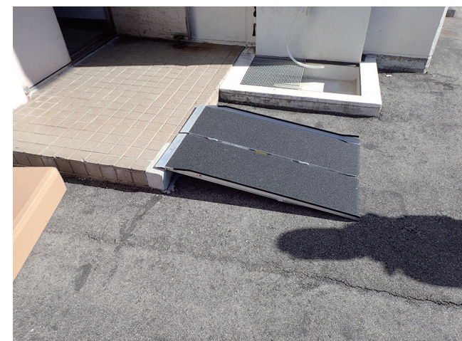
車いす用の段差解消スロープ
