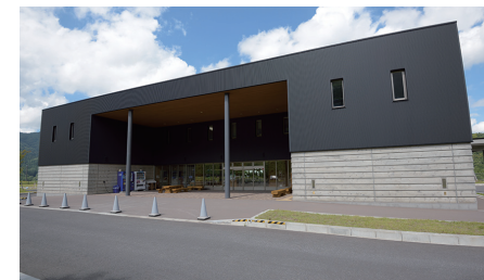
トイレがあるダム管理棟
