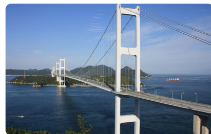
来島海峡大橋 (四国地方整備局・本州四国高速道路株式会社 / 愛媛県今治市)
