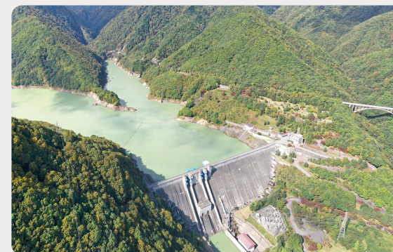
ガイド付き見学 (長野県 大町ダム)
