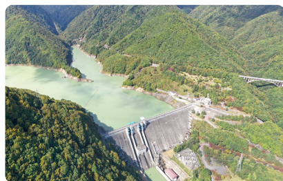
大町ダム (北陸地方整備局 / 長野県大町市)
