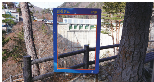
ダムの全景が見える視点場
