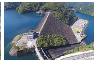
▲Rock-fill dam (Kuzuryu Dam)
