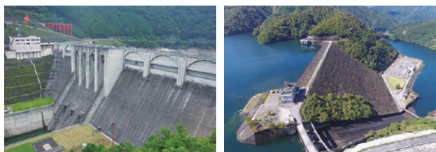
▲重力式コンクリートダム(大滝ダム)
