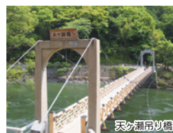
天ヶ瀬吊り橋
