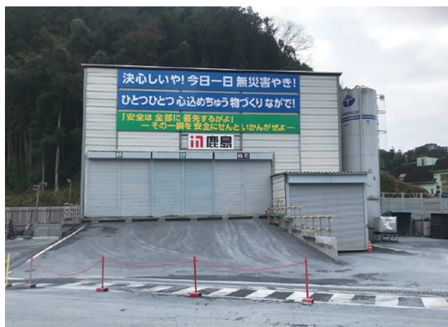
バッチャープラント
