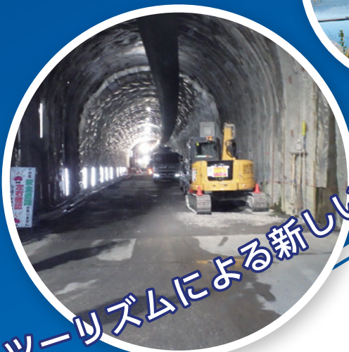
日下川新規放水路
