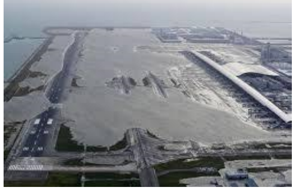
平成30年台風第21号による浸水(関西国際空港)
