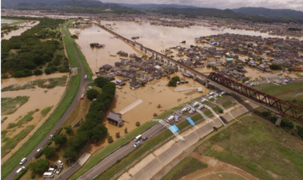
平成30年7月豪雨による被害(高梁川水系小田川)
