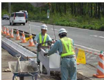
U形側溝設置作業
