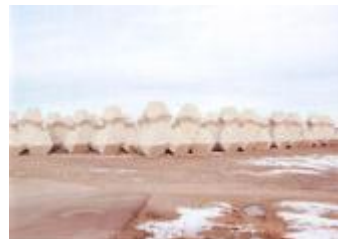
フライアッシュ混合コンクリートの使用事例（能代港重要港湾改修工事）
