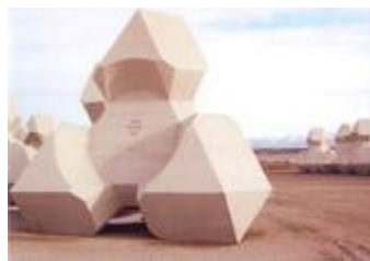
フライアッシュ混合コンクリートの使用事例（能代港重要港湾改修工事）
