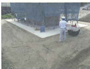
<構造物埋戻し利用状況>
