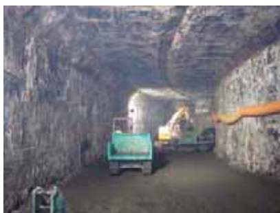
内部掘削状況
