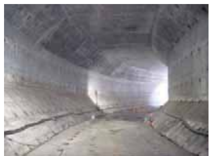
躯体構築完了
