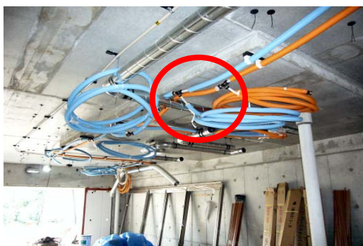
分岐点のプレカットによる工場加工
