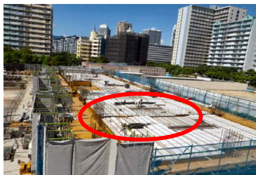
スラブにPC板を使用することにより、型枠を使用しない
