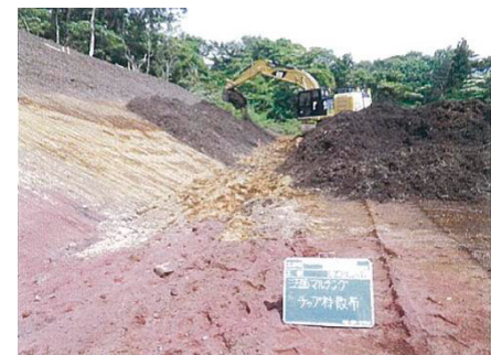
チップ材敷設状況
