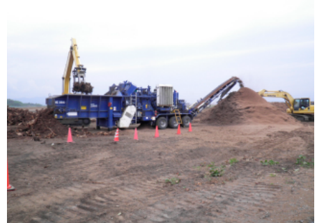
伐採材の破砕状況
