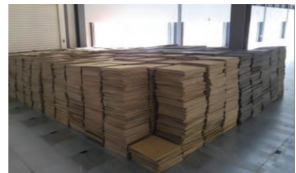
タイルカーペット取り外し状況
