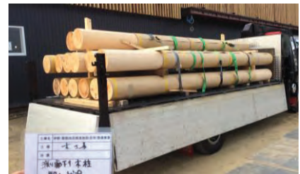
柱プレカット搬入状況
