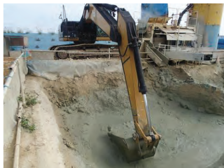
建設汚泥の固化状況
