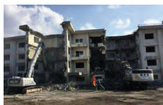
既存建物解体
