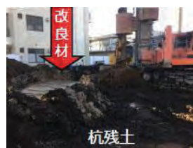
建設汚泥の改良
