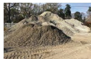
再生碎石を現場内敷均し
