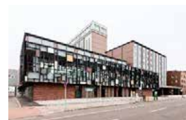
図-6 減築、改修工事了
