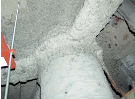
鉄骨耐火被覆
