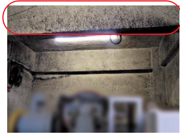
機械室吸音材
