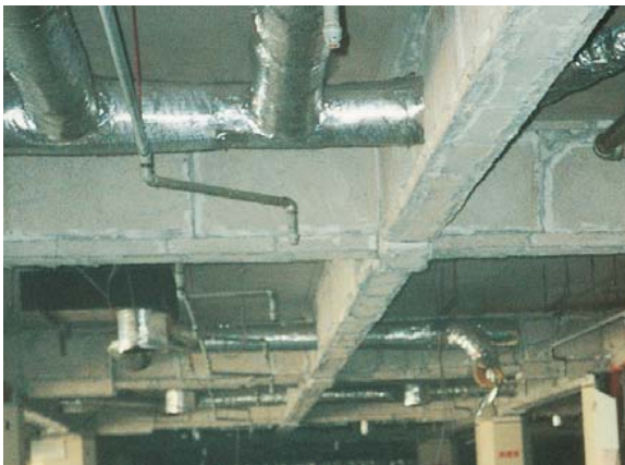
鉄骨耐火被覆
